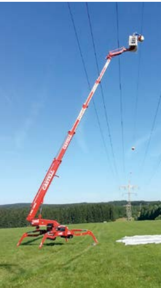
▲ Hochspannung: Damit die Flugwarnkugeln von Hochspannungsleitungen dauerhaft ihre Aufgabe erfüllen können, müssen sie von Zeit zu Zeit neu lackiert werden. Um der Stromtrasse auch durch unwegsames Gelände folgen zu können, hatte sich das Fachunternehmen aus dem Mietpark von Castell eine Teupen Leo30 Raupenbühne geholt. (Bild: Castell Arbeitsbühnen)
