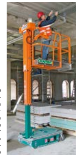
▶ Alternative: Auch im Ausbaugewerbe werden die kleinen Vertikalbühnen als Aufstiegshilfe immer beliebter – der Power Towers IL 4,5 A Nano SP im Mietprogramm von Cramer ist eine gute Alternative zu den gefährlichen Leitern. Wegen seiner Ausschubplattform benötigt er wenig Platz, erreicht auch schwer zugängliche Arbeitsbereiche und passt durch Standard-Türen sowie in einen üblichen Aufzug. (Bild: Cramer Arbeitsbühnen)
