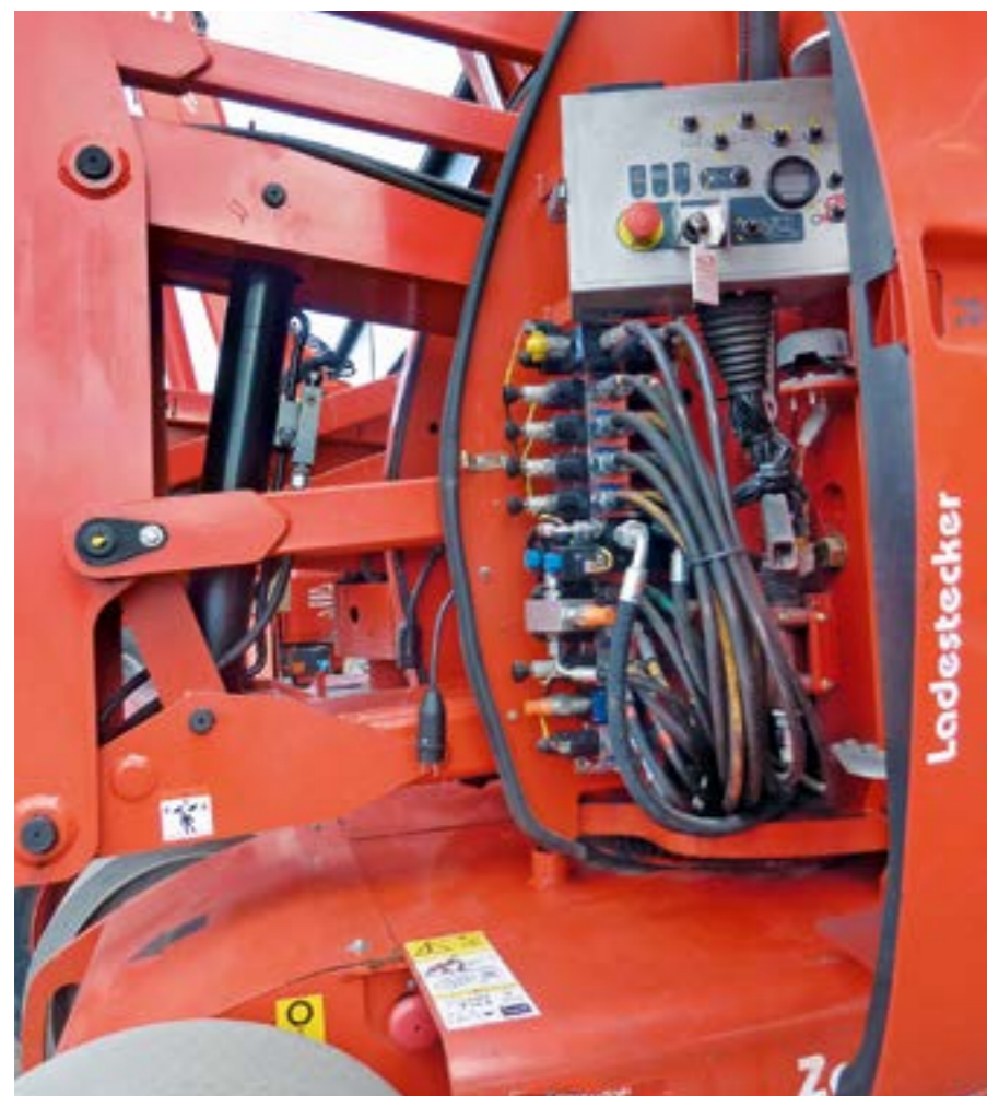
Sicherheitsfaktor: Die Hydraulikschläuche von Hubarbeitsbühnen sind sicherheitsrelevante Verschleißteile, die regelmäßig überprüft und ausgewechselt werden müssen – je nach Beanspruchung alle zwei bis sechs Jahre. Das digitale „Schlauchmanagement 2.0“ schafft dabei Transparenz und Rechtssicherheit. (Bilder: Späth/HansaFlex)
