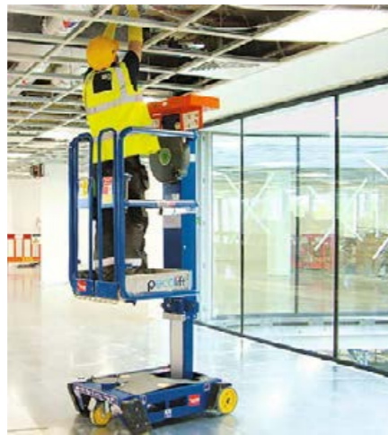
Sicher und schnell: Der Parallelversuch in zwei identischen Stockwerken desselben Projekts brachte überzeugende Ergebnisse zugunsten des Pecolifts. Nicht nur weniger Absturz- bzw. Verletzungsrisiko, sondern auch noch 15 bis 20 Prozent mehr Arbeitsproduktivität.
