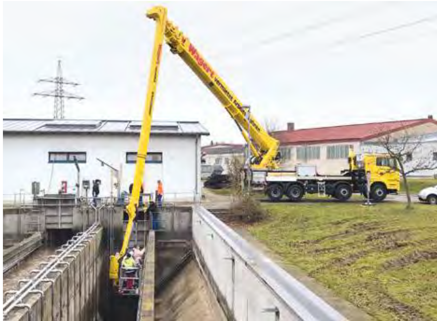
▲ Verkehrte Welt: Statt in die Höhe ging es mit dieser in Diensten von Vermieter Wagert stehenden Palfinger L 640 auf MAN-Chassis in die Tiefe – zur Kontrolle einer Stützmauer in der Kläranlage Bayreuth war weniger die maximale Arbeitshöhe der Lkw-Arbeitsbühne von 64 m gefragt, als die flexible und exakte Positionierung des Arbeitskorbs mit 2 × 220 Grad Korbdrehung sowie bis zu 40 m seitliche Reichweite.
