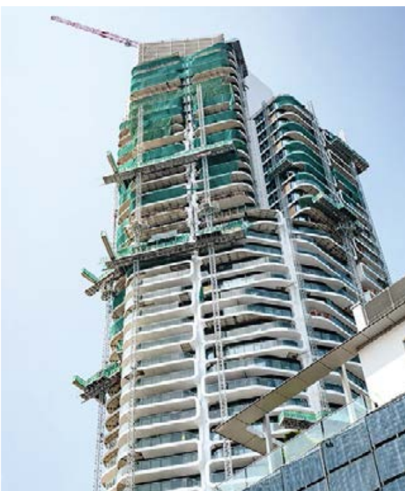
◀ Fassadenkletterer: Die Glas-/Alu-Fassade am Grand Tower in Frankfurt, dem mit 165 m höchsten Wohngebäude Deutschlands, ist fast abgeschlossen. Für die Montage der komplexen Fassadenstruktur mit verschiedenen Balkontypen, zahlreichen Vor- und Rücksprüngen hat Scandlimber Deutschland über 30 Kletterbühnen unterschiedlichster Konfiguration aufgebaut: jeweils zwei Bühnen an einem Mast übereinander, elektrisch ausfahrbare Verbreiterungen oder bis zu 5,50 m ausfahrbare Stege – der Abtransport nach Projektende umfasste 50 Lkw-Ladungen, darunter insgesamt 1.750 Mastsektionen! (Bild: Scandlimber)
