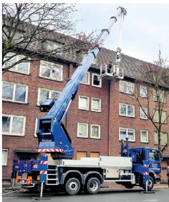
◀ Gut kombiniert: Mit seinem 52 m Teleskopausleger und maximal 12 t Nutzlast ist der AK 52 von Böcker mal als Autokran der 26-t-Lkw-Klasse mit stattlichen Reichweiten unterwegs, kurz darauf schon als flexible Hubarbeitsbühne. Der speziell dafür entwickelte Arbeitskorb mit bis zu 600 kg Korblast und zwei Steuerständen wird per Schnellwechselsystem montiert und kann hydraulisch auf 3,5 m verbreitert und um 400° gedreht werden. Bereits unmittelbar nach der Inspektion am Dach einer Wohnanlage werden die benötigten Baustoffe an ihren Einbauort gehoben. (Bild: Böcker Maschinenwerke)
