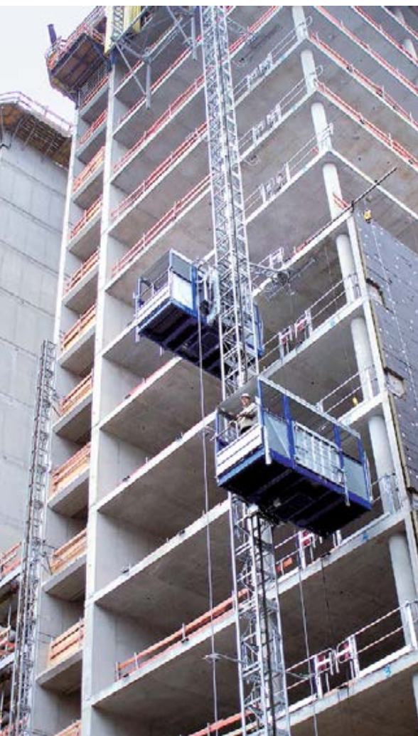
Unterschätzte Gefahren: Bei nicht fachgerechter Bedienung stellen auch vermeintlich einfache Maschinen wie Bauaufzüge ein beachtliches Unfallrisiko dar – deshalb bietet IPAF dafür jetzt spezielle Bedienschulungen an. (Foto: Böcker)
