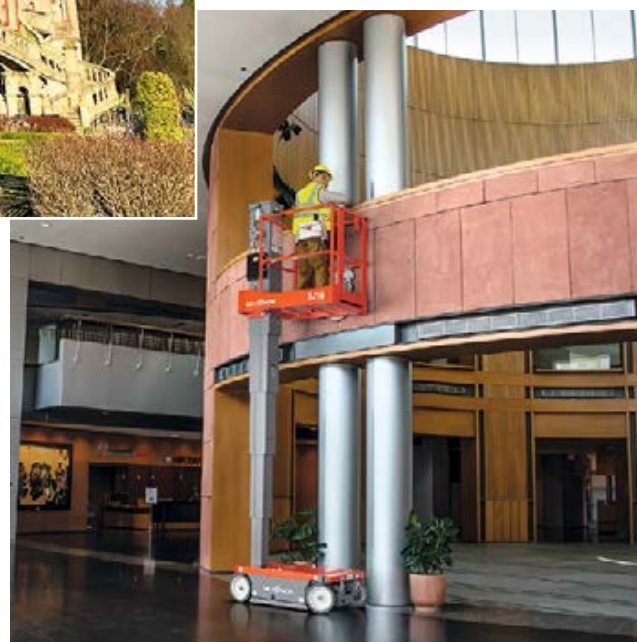
▲ Senkrechtstarter: Die Nachfrage nach Vertikalbühnen ist in Europa innerhalb der letzten Jahre enorm gestiegen. Haupteinsatzfelder sind Inneneinsätze, bei denen sie eine sicherere Alternative zu Fahrgerüsten und Leitern bilden, wie diese Skyjack S16 bei Reinigungsarbeiten in einem Kongresszentrum. Mit weniger als 1.000 kg Eigengewicht kann sie problemlos im Lift von Stockwerk zu Stockwerk mitgenommen werden, und mit entsprechendem Zubehör auch für Außeneinsätze fit gemacht werden. Dadurch wird ihre Vielseitigkeit weiter erhöht. (Bild: Skyjack)
