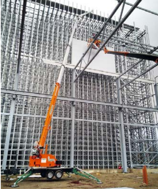
▲ Teamwork: Bei der Montage der Fassadenverkleidung dieses neuen Hochregallagers kam es auf präzise Bewegungen in der Höhe an. Der auf dem unebenen Gelände auf seinen vier Schwenkstützen sicher positionierte Böcker Anhängerkran wurde dazu aus dem Arbeitskorb der Manitou Hubarbeitsbühne per Funkfernsteuerung feinfühlig dirigiert. Damit standen die beiden Maschinen aus dem Cramer Mietpark für einen sicheren Betrieb und zügigen Arbeitsfortschritt. (Bild: Cramer Arbeitsbühnen)
