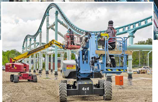
▲ Nervenkitzel: Eine Teleskopbühne auf Ketten und eine Gelenk-Teleskopbühne aus dem Mietpark von Zeppelin Rental beim Test-Aufbau einer Achterbahn. Die 37 Schienensegmente mit Stromschiene und Zahnstange wurden in Güstrow nur versuchsweise montiert – in Betrieb gehen wird das rasante Fahrgeschäft jedoch in einem Themenpark auf dem größten je in Deutschland gebauten Kreuzfahrtschiff „Global Dream“, das derzeit in einer Werft in Wismar liegt. (Bild: Zeppelin Rental)
