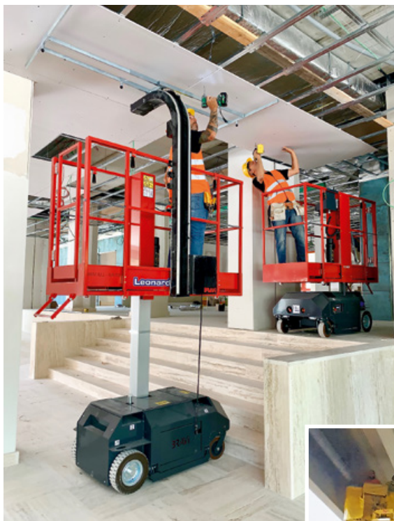
▲ Montagehelfer: Kleine Personenlifte wie dieser kürzlich aufgewertete Leonardo HD von Bravi erweisen sich nicht nur im Innenausbau als nützliche und sichere Helfer, beispielsweise wie hier bei der Montage von Deckenpaneelen. Diese 560 kg schwere Aufstiegshilfe kann auf der Stelle drehen, ist damit extrem manövrierfähig. (Bild: Bravi)
