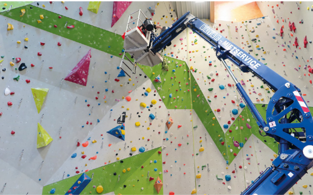
◀ Neue Kletterroute: In einer Kletterhalle stellt die Raupenarbeitsbühne RAB 183 GT D/E von Beyer Mietservice mit 18,30 m Arbeitshöhe eine wichtige Arbeitsgrundlage bei der Montage und Wartung der Griffe in der Wand dar. Durch ihren Kombiantrieb kann die Bühne sowohl innen als auch außen effektiv genutzt werden – ihre Steigfähigkeit und Wendigkeit und die damit verbundene Flexibilität sind wichtige Auswahlkriterien. Ein weiterer Pluspunkt beim Halleneinsatz sind die bodenschonenden Gummiraupen.
