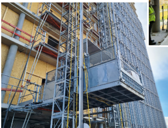
Einfache Beladung der Transportbühnen über stabile Rampen und Ladestellendecks mit bis zu vier Tonnen Nutzlast.
