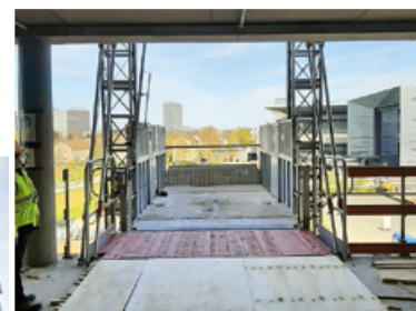
Einfache Beladung der Transportbühnen über stabile Rampen und Ladestellendecks mit bis zu vier Tonnen Nutzlast.
